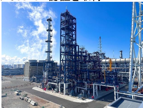
SAF製造設備
