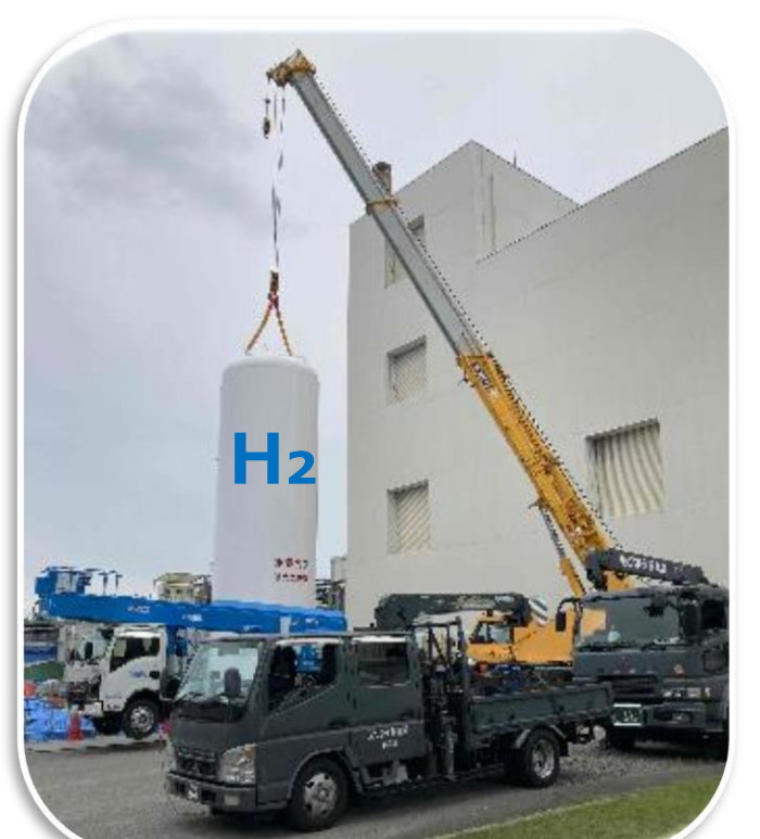
水素タンク設置
