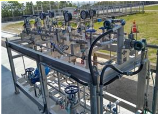
新設：減圧ユニット
