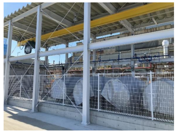
Fig. ガラス熔解炉での実証試験状況 (左) 及び試験に使用したアンモニア貯槽 (右).
