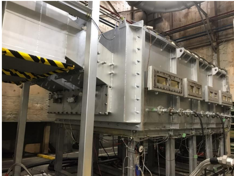
200kW 燃焼試験モデル炉
