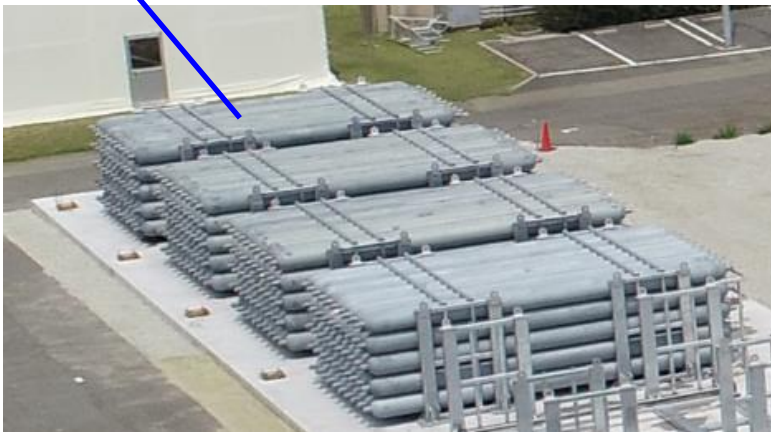
(参考)既設350本 : 全7基中、4基を据付時点
