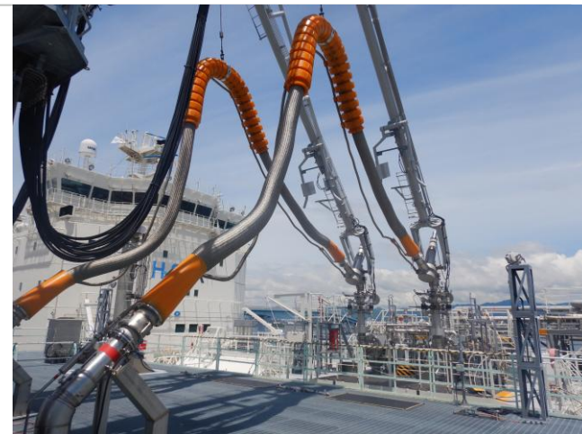
荷役試験実施中の状況
