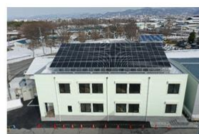
図1 実証施設の全景
