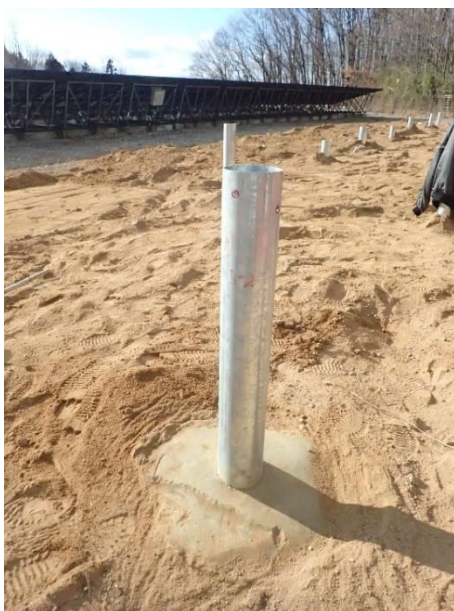
柱状改良杭に鋼管杭埋設
